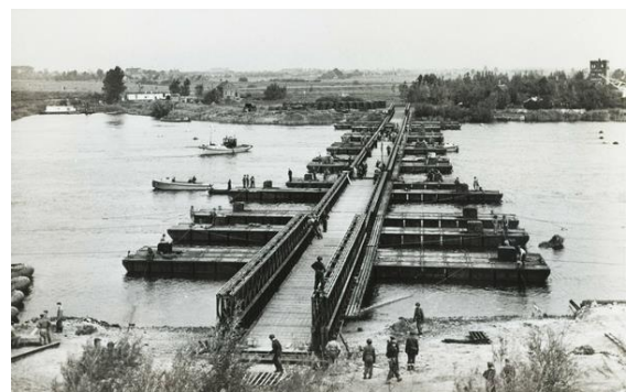
112 Pontonniersbataljon legt een KL 70 Baileybrug op drijvers inde Bergse Maas; november 1954 (Bron: beeldbank NIMH).
