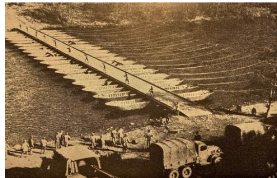
Dekliggerbrug M4 (Rivierovergangen).
